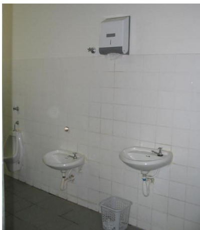
Figura VII - Lavatório, EMEIF Eluiza Resende Rodrigues
