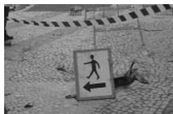
Figura 3 e 4: placa pintada à mão seguindo o pictograma oficial utilizado em sinalizações brasileiras, mas com as cores alteradas, e colocada fora da área de visão. Passagem estreita e sem proteção para o pedestre (Av. Atlântica). Fonte: MENDES, mar. 2007.
