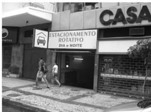
Figura 17: placa de sinalização de entrada e saída de garagem, longe da linha de visão dos pedestres. No período do dia o barulho e o movimento intenso prejudicam ouvir a sirene e ver o sinal luminoso, tanto por parte dos pedestres quanto dos motoristas que utilizam a garagem. Fonte: MENDES, nov. 2007.
